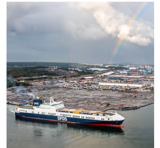
Pågående kajbygge av Arendal 2, etapp 1c.
